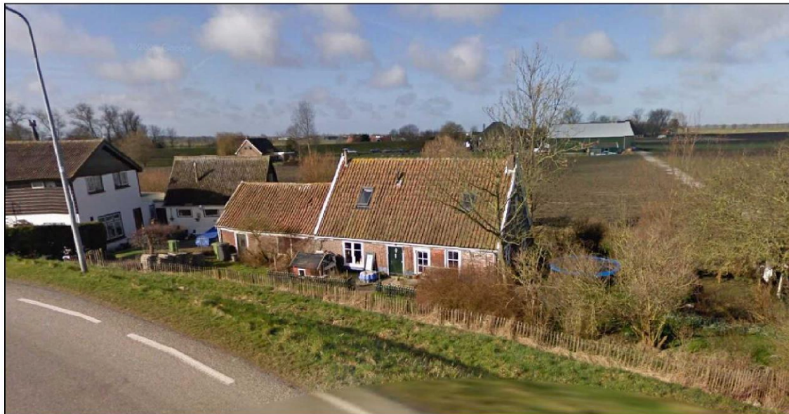
Afbeelding 1. De woning Kreil 17 in Barsingerhorn in 2009, gezien vanaf de Westfriese Omringdijk (bron: Google Streetview).
