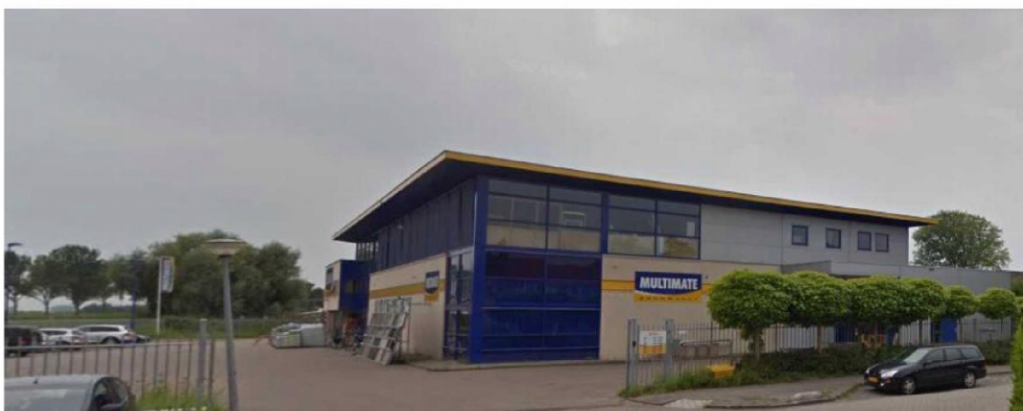
Noordzijde zicht vanaf Smidsweg
