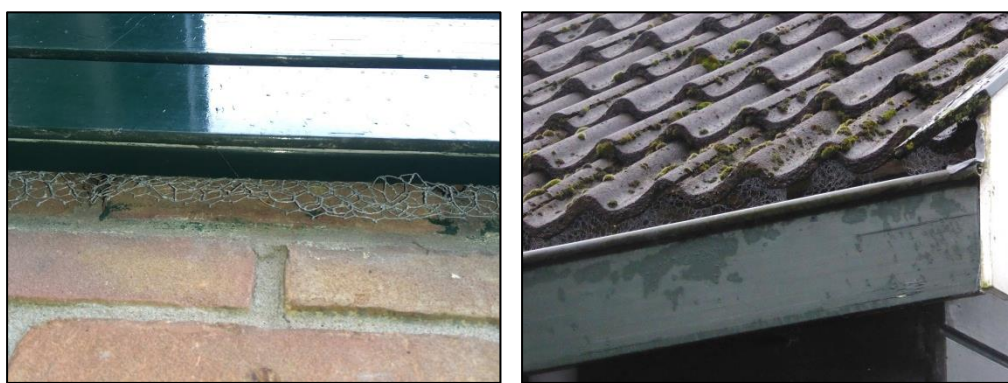
Alle openingen onder de dakrand en onder dakpannen zijn afgedicht met kippengaas.
