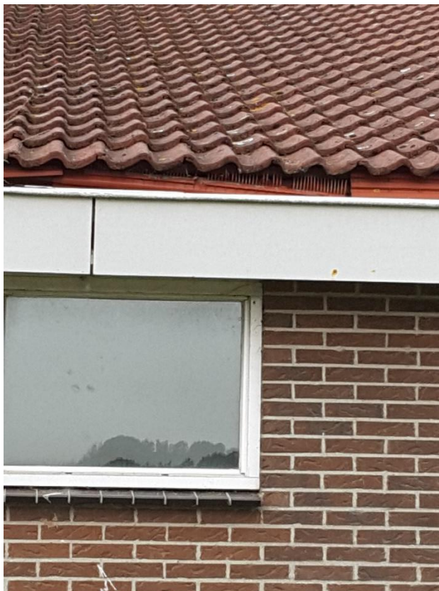
Dakrand met vogelwerend materiaal
