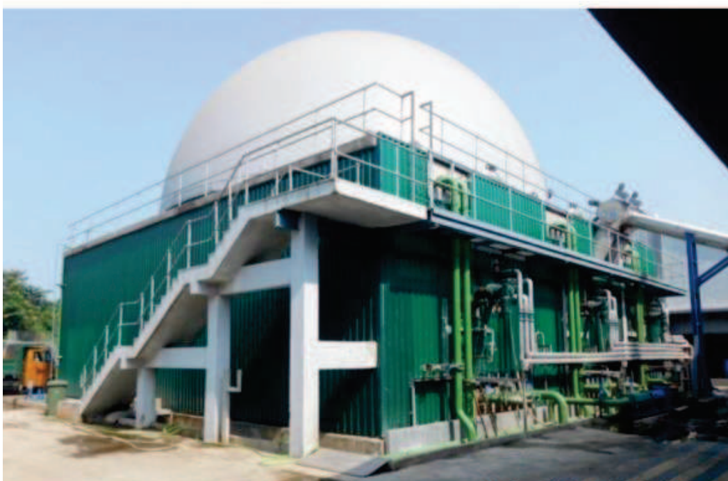
Industriële Biogas module (project in India), voor en na het aanbrengen van het isolatie en plaatwerk.
