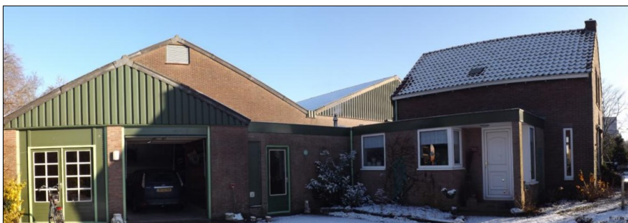
Figuur 1. Te slopen bebouwing
