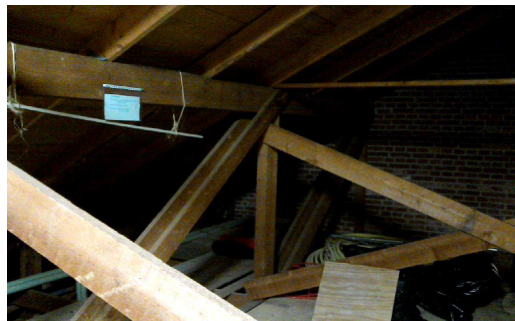
Foto 6: Houten dakconstructie en dakbeschoeiing
