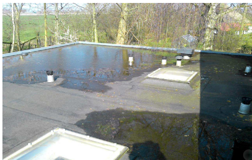
Foto 18: Doorvoeringen van metaal of pvc
