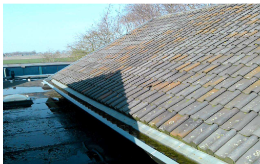
Foto 15: Deel dak gedekt met dakpannen
