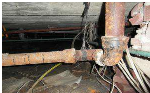
Foto 14: Riolering van gietijzer
