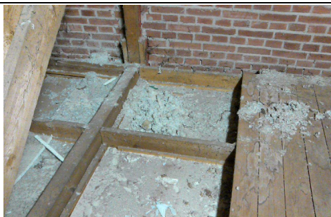
FOTO 1 | Isolatiemateriaal niet asbesthoudend
