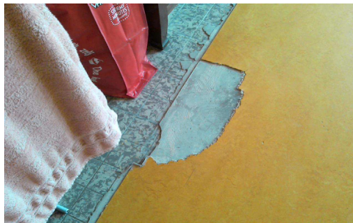
Foto 7: Linoleum gelijmd op egaline op tegels
