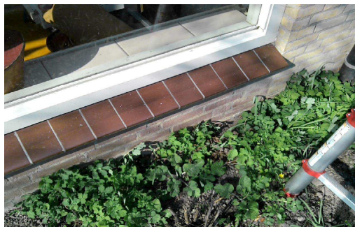
Foto 19: Lekdorpel niet asbestverdacht
