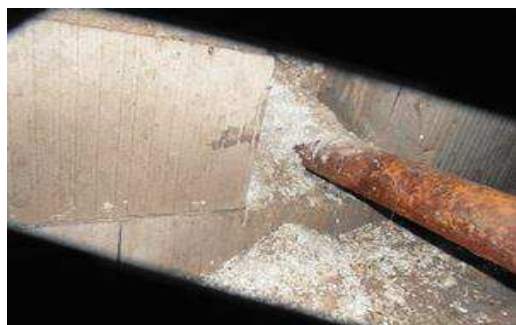
Foto 12: Kruipruimte met niet asbesthoudend isolatiemateriaal
