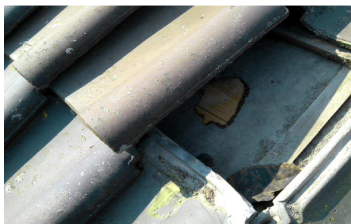
Foto 17: Onder de dakpannen schoon dakbeschot met een laag niet asbestverdacht bitumen
