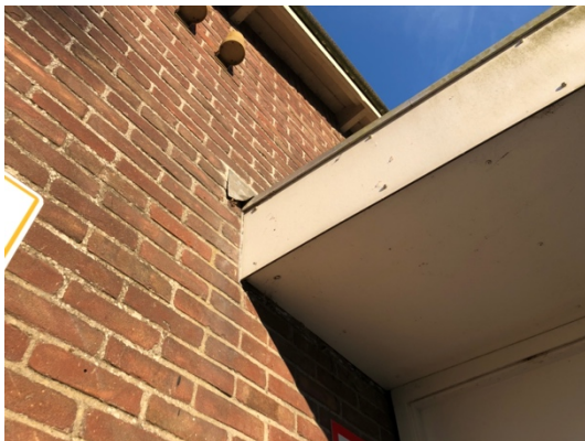
Kieren tussen loden afwerking
