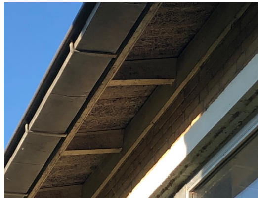
Kieren naast de OSB-platen
