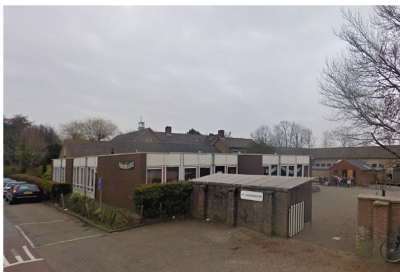
afb.13 Verbetering uitstraling gebouw aan zijde Ooievaarsweg gewenst
