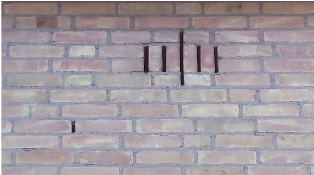
Spouwgaten geschikt als verblijfplaats voor vleermuizen
