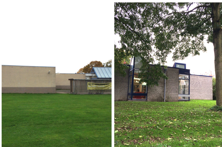
Afbeelding 6 & 7. De gevel en het dak van het winkelcentrum (links) en die van het te slopen pand (rechts).
