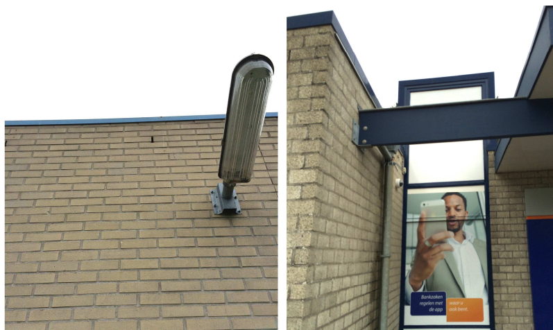
Afbeelding 8 & 9. De buitenmuur van de supermarkt(links) en de buitenmuur van het te slopen pand (rechts)
