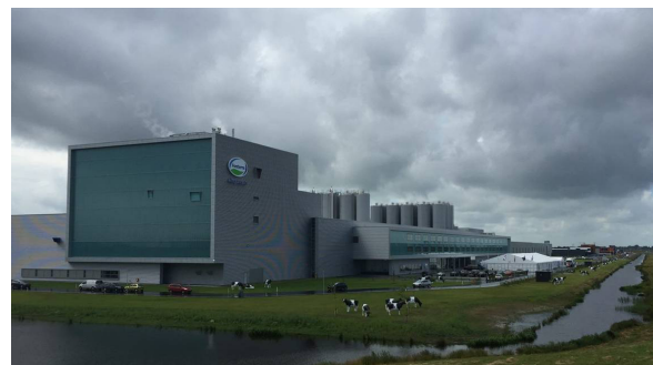
Referentie hoog bouwwerk, melkfabriek Heerenveen
