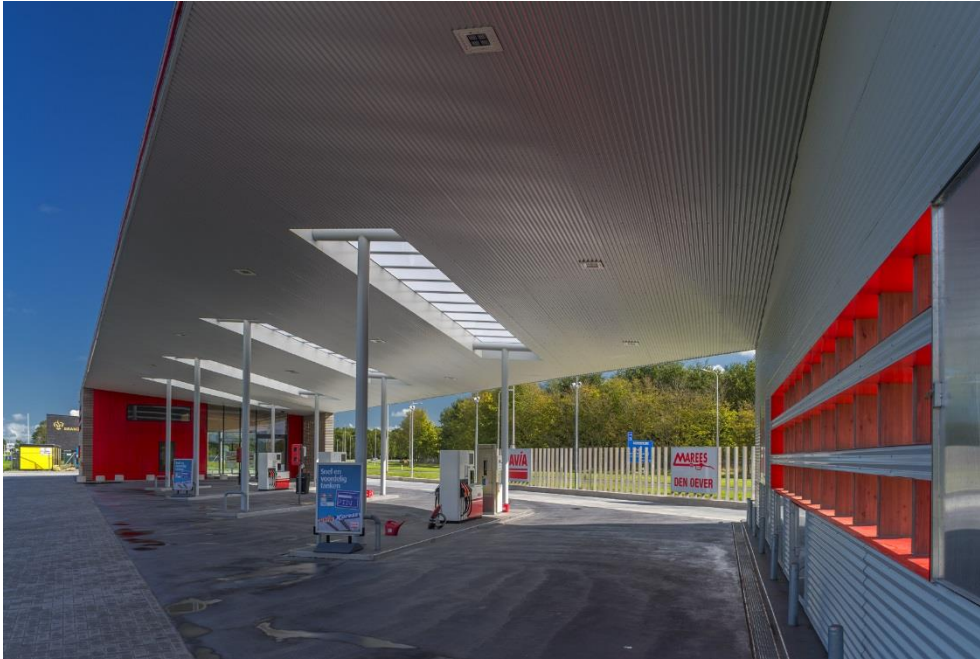
figuur 8 : Referentiebeeld: Het nieuwe tankstation te Den Oever
