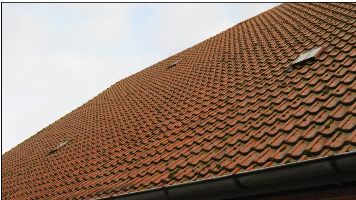
Afb 10: Pannen liggen strak en zonder schade. Geen mogelijkheden voor vogels om onder de pannen te komen
