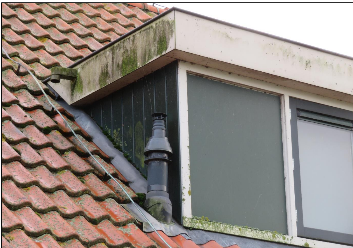
Afb 11: Geen naden en kieren in de dakkapel
