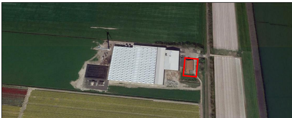
Afb 2: In het rode kader de te slopen woning met schuur
