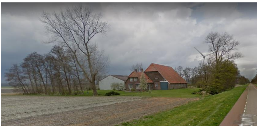
Zicht op Noorderdijkweg 17 vanuit zuidelijke richting
