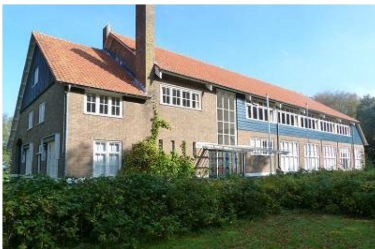
afb. 30 Het voormalige gemeenschapshuis is van algemeen belang wegens cultuur- en architectuurhistorische waarde als historisch-functioneel hoofdonderdeel van het complex Joodse Werkdorp Nieuwsluis (foto: gemeente Hollands Kroon)
