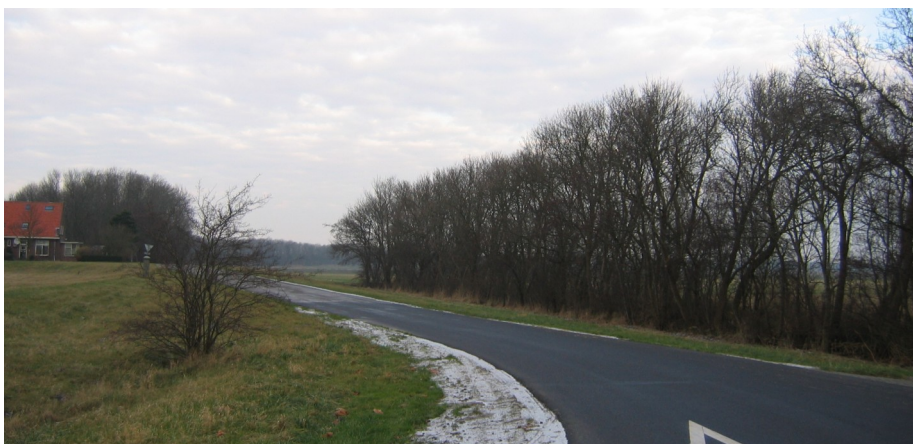
Weg over de westelijke Wieringermeerdijk (Waardweg)
