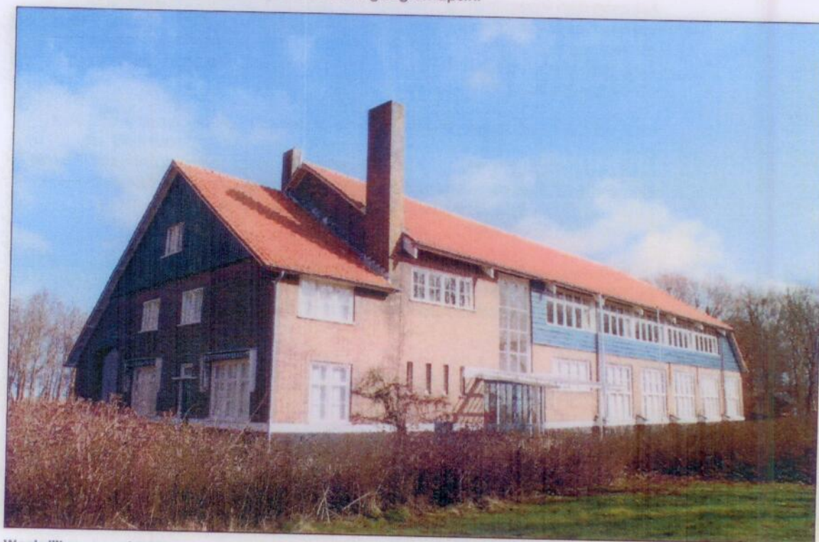
Westelijke- en zuidelijke gevel. Bron: bouwtechnische opname Vitruvius.
