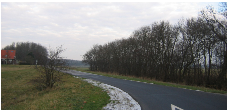
Weg over de westelijke Wieringermeerdijk (Waardweg)
