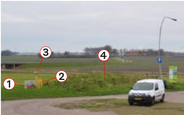
Markeringspalen kabels en leidingen
