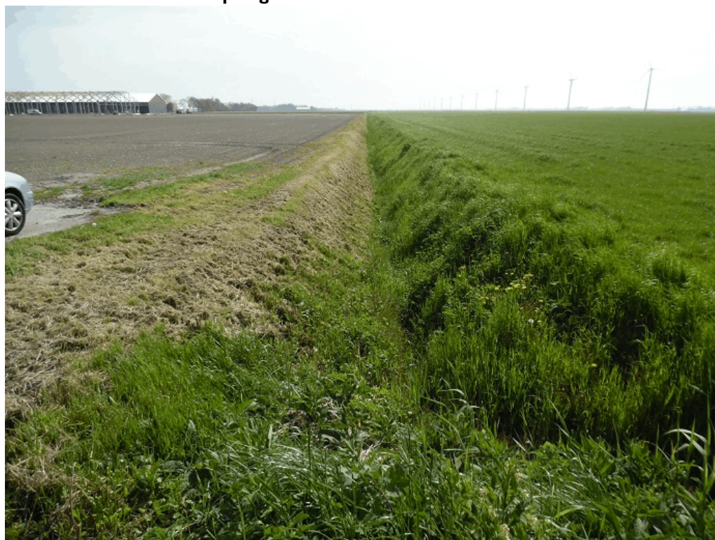
Sloot ten zuiden van het plangebied
