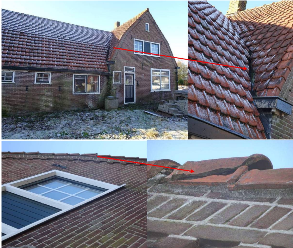
Figuur 3. Beeld van potentiële verblijfplaatsen van vleermuizen in de woning aan de Koggeweg 4 't Veld op vrijdag 1 december 2023.
