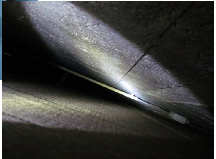
Golfplaten met uitsparingen en ruimte tussen systeemplafond en betonnen overspanning
