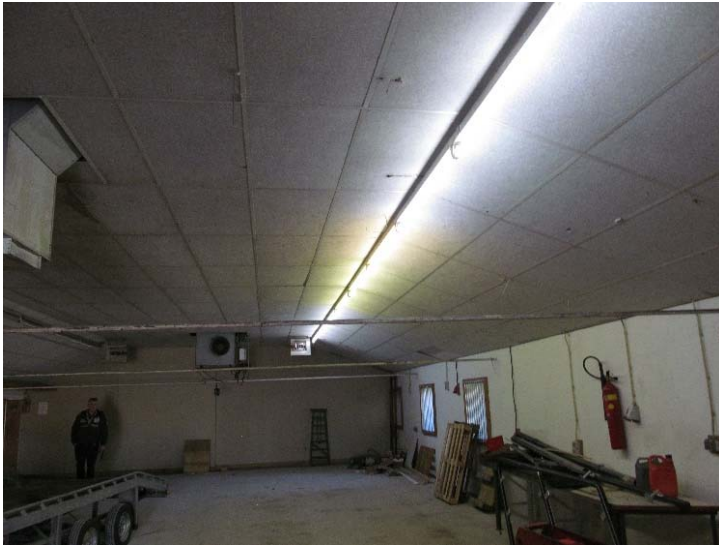
Zuidelijke bedrijfsruimte met systeemplafond
