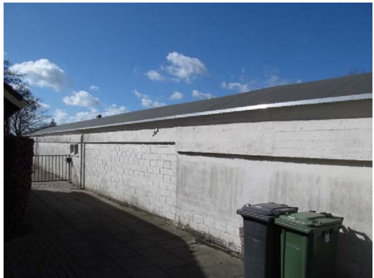
De bedrijfsruimte zuidzijde met tegelpad
