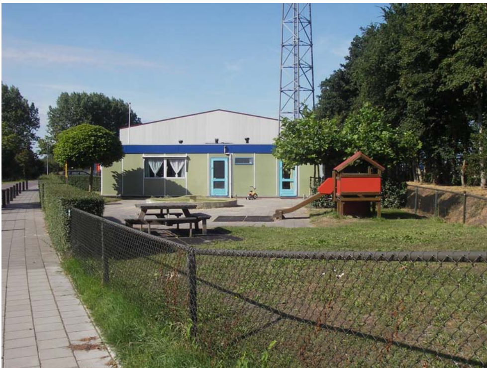
Figuur 6: Hippolytushoef, locatie Rozenlaantje; het plangebied gezien vanaf het Rozenlaantje in westelijke richting.
