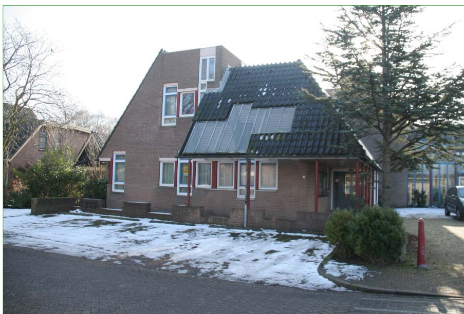
De noordwest kant van het aanwezige gebouw in het plangebied.
