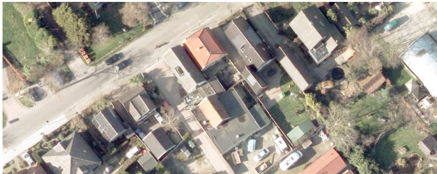
↓ Fragment luchtfoto bestaande bebouwing
