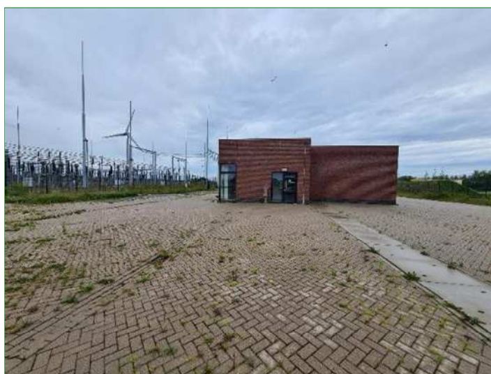
Een gebouw ten zuidoosten van het gebied waar de transformatorruimte wordt gebouwd.
