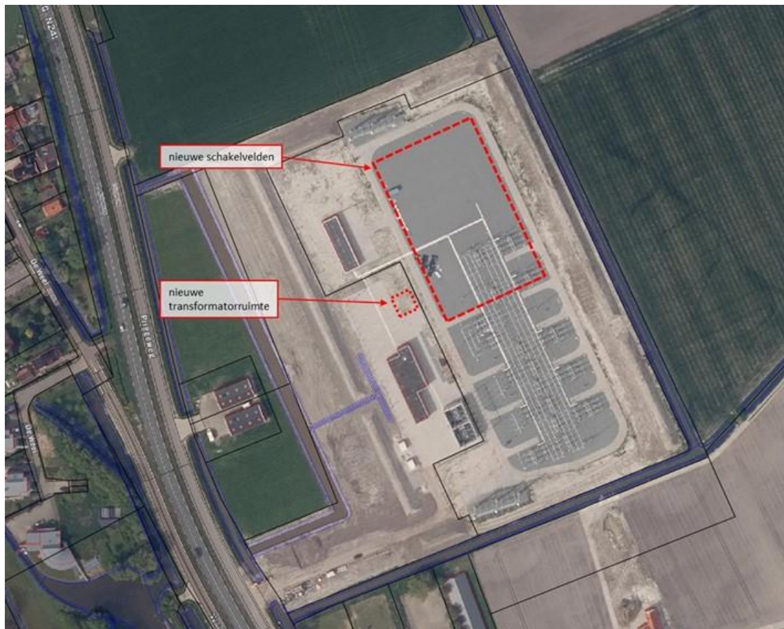
afbeelding 5: uitbreidingen aangeduid op luchtfoto van het transformatorstation (bron luchtfoto: pdok.nl)
