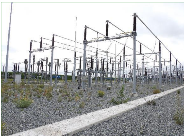
De electriciteitsmasten die moeten worden verlengd.
