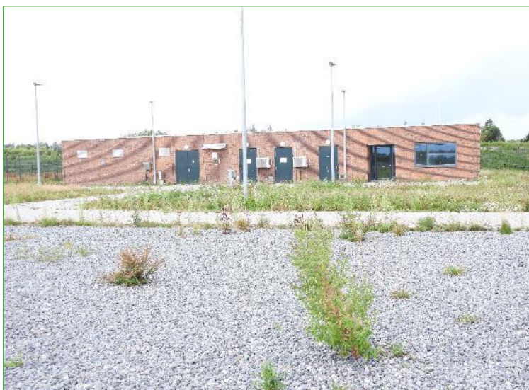
Aanwezige bebouwing op enige afstand. Hier zijn geen gaten of kieren waargenomen.
