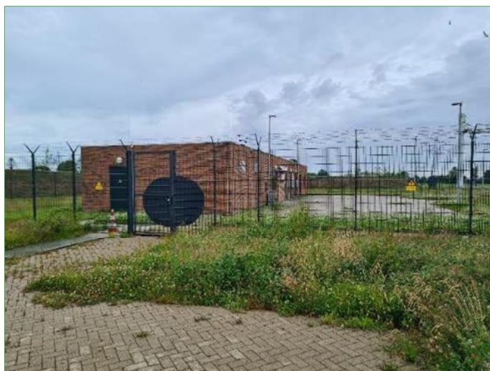
Een gebouw van TenneT ten noordoosten van het gebied waar de transformatorruimte wordt gebouwd.
