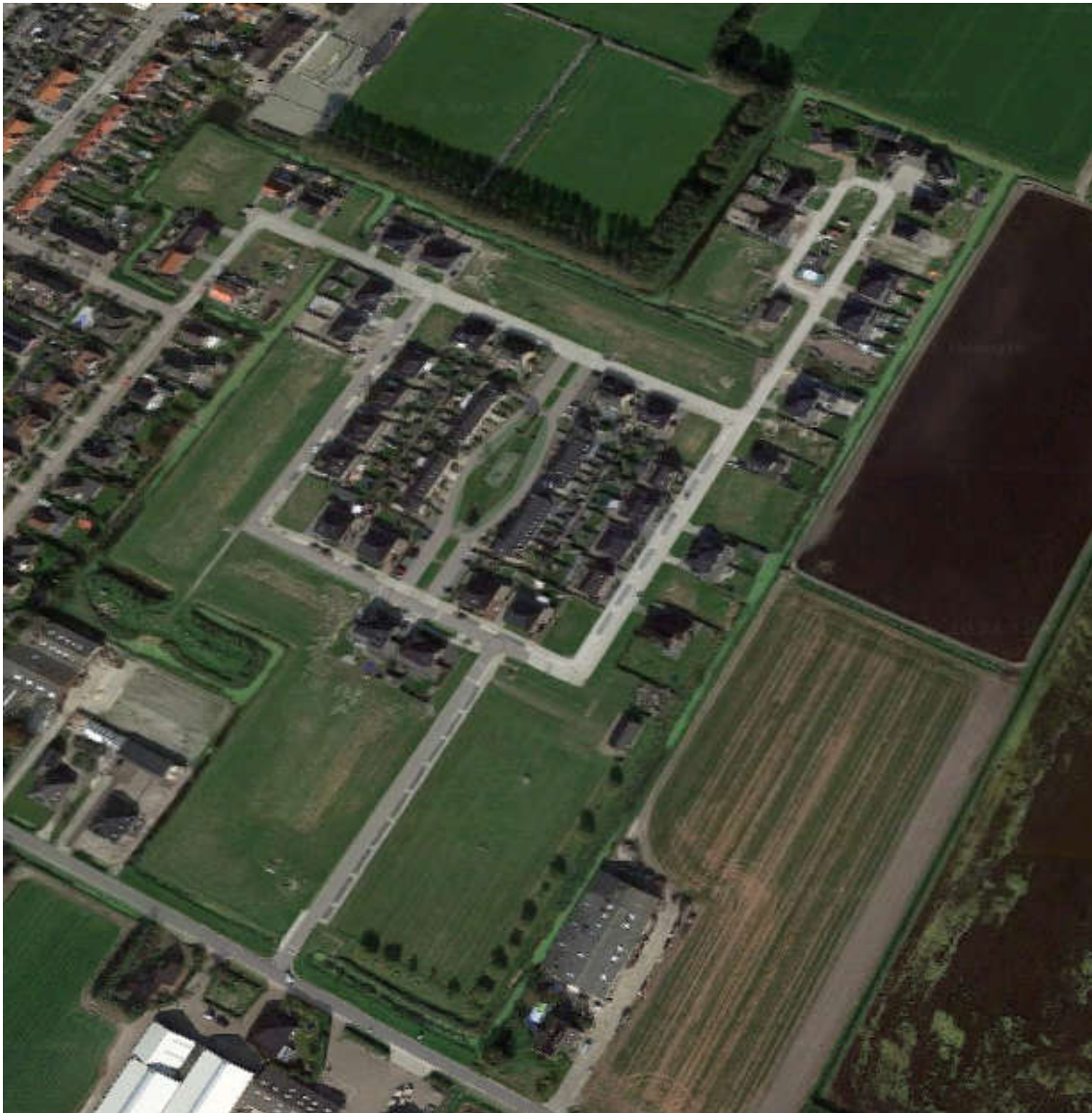
Afbeelding 2.1: Luchtfoto huidige situatie
