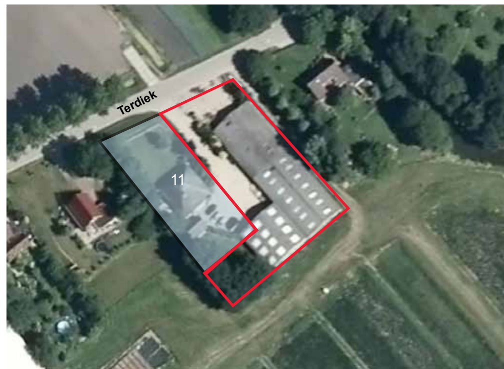
Luchtfoto huidige situatie plangebied Terdiek 11, Nieuwe Niedorp, globale aanduiding locatie; het rood omlijnde gebied is de planlocatie, het grijs omlijnde gebied is niet in eigendom van de initiatiefnemers
