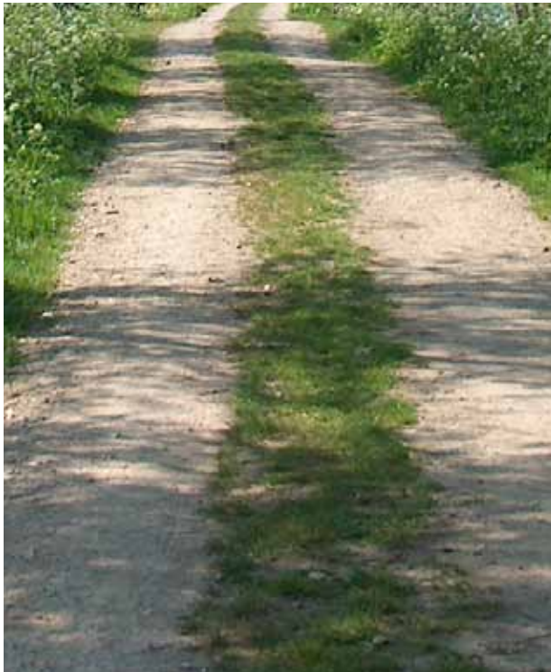
Referentie, oprit van halfverharding, in vorm van karrespoor
