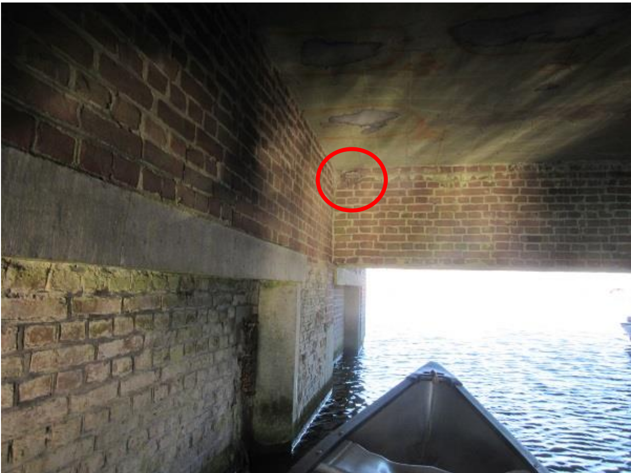
Figuur 3. Zwaluwnest onder de brug.
