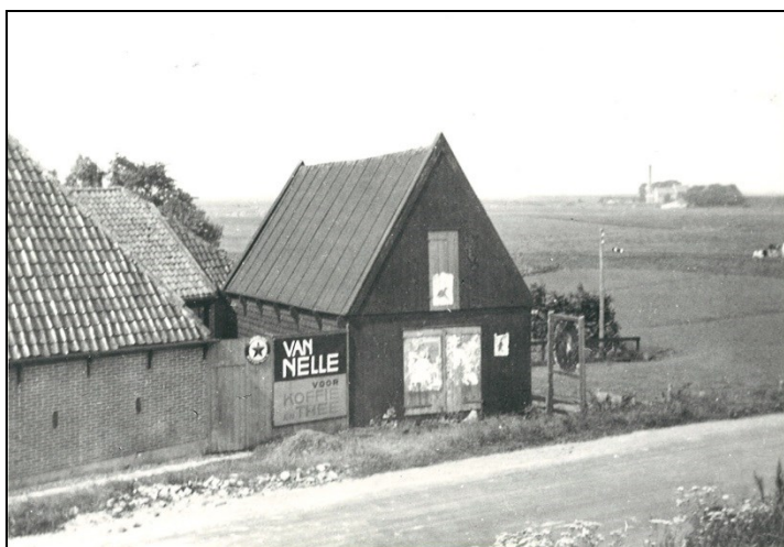
Foto van het dijkmagazijn voor de afbraak in 1970 (collectie Hoogheemraadschap).
