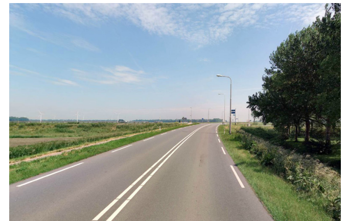
N239 richting kruising Langereis / Westfriese Omringdijk
