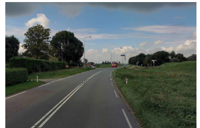
N239 richting kruising Zuiderzeestraat - Koggenrandweg
