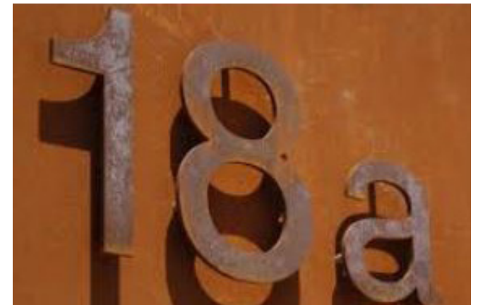
Aanbrengen belettering op cortenstalen wand
