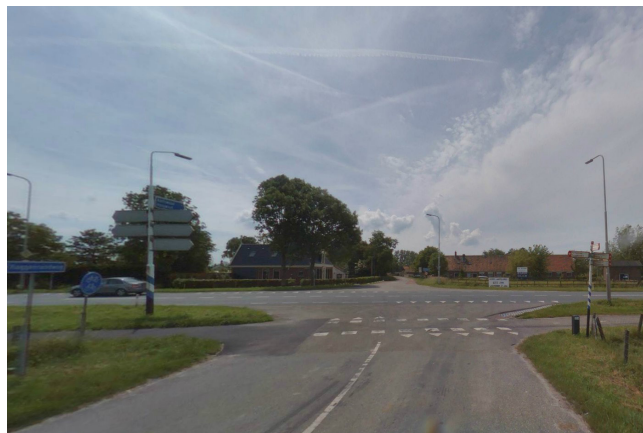
Kruising Koggenrandweg- Zuiderzeestraat met N239
