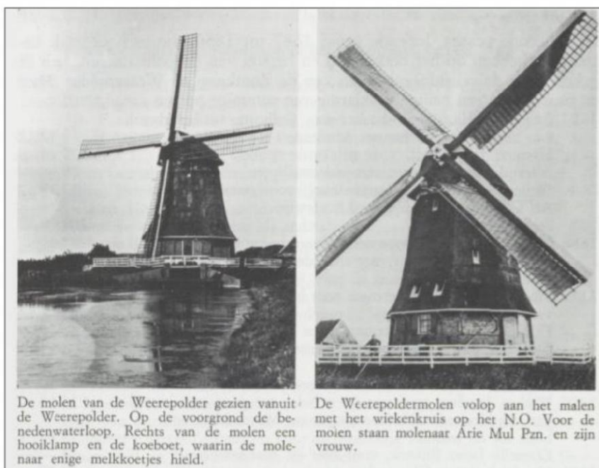
Figuur 2.1: De molen van de Zoutkaag- en Weerepolder. Bron: West-Friesland Oud & Nieuw 1977.
