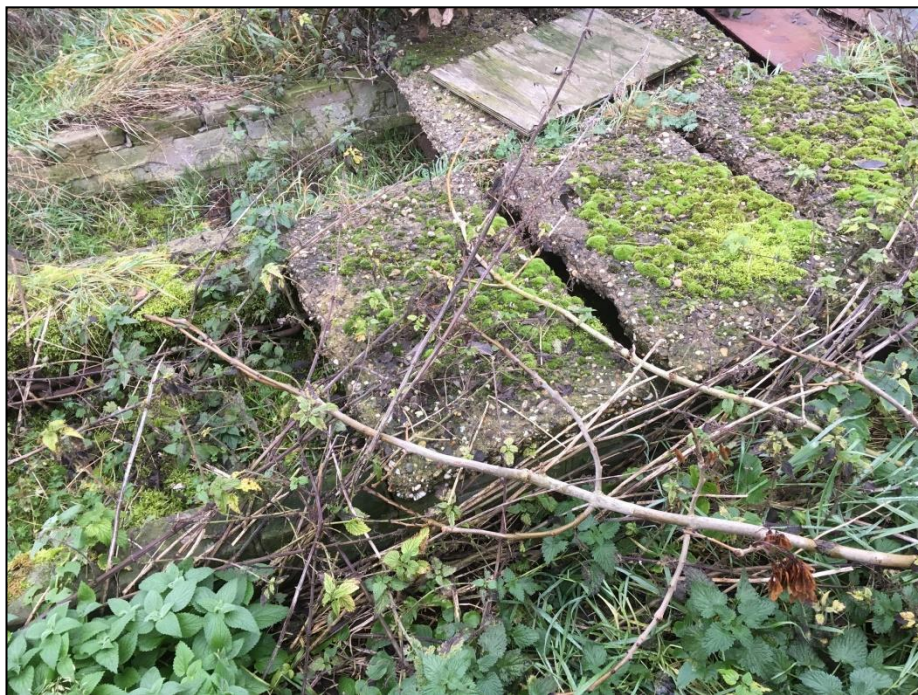
Figuur 16 Sleuven in bodem, afgedekt met tegels en metalen platen
