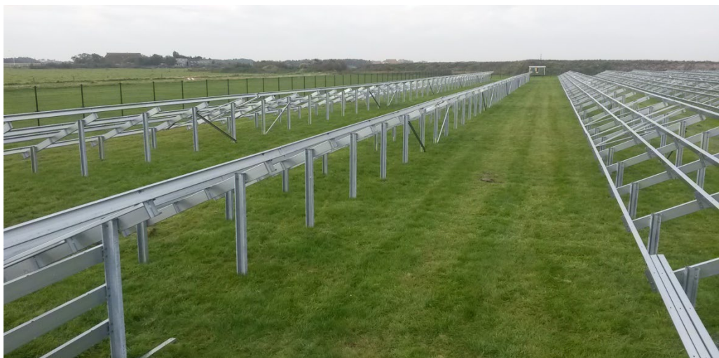
Figuur 4.4 Foto ter illustratie van installatieframe voor bevestiging zonnepanelen
