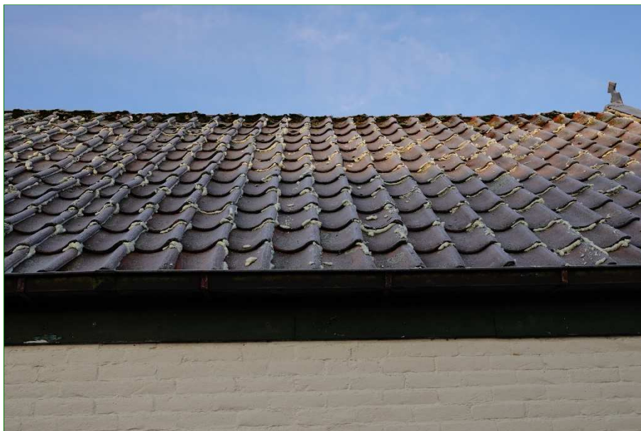
Er zijn geen kieren tussen dakpannen of aan de onderkant ervan.
