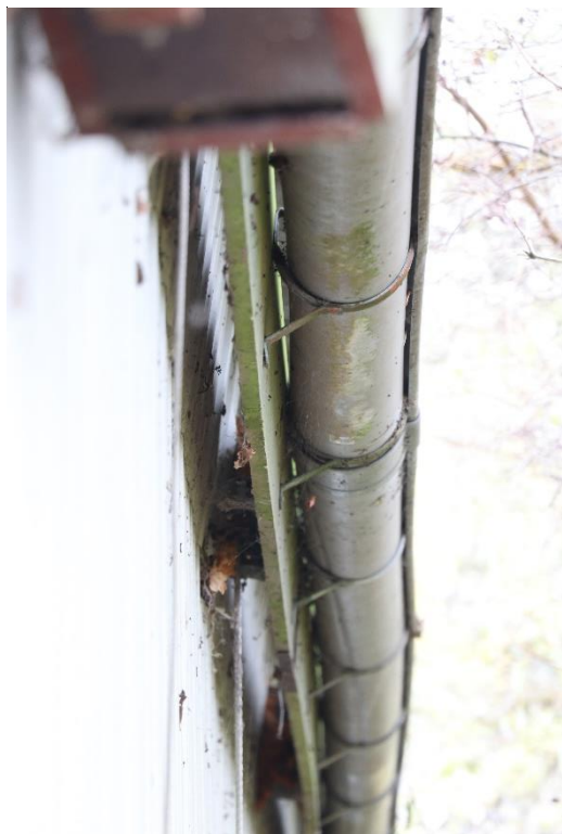
Figuur 11. Ruimtes langs de dakrand van de schuur.
