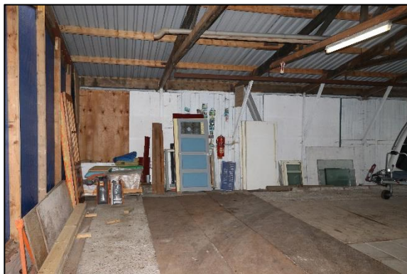
Figuur 7. Binnenzijde van de caravanshuur. noordoostelijke kijkrichting.
