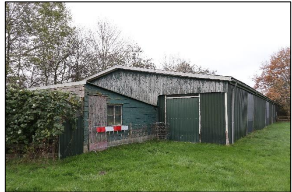
Figuur 4. Achterzijde caravanshuur met leegstaand kippenhok. Noordwestelijke kijkrichting.
