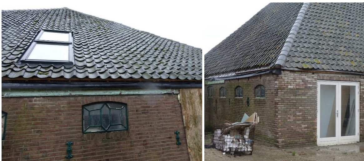
Figuur 3. Beide daken van de stolp zijn voorzien van folie en nieuwe panlatten
