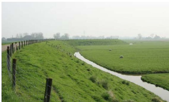
Karakteristiek beeld Westfriese dijk
