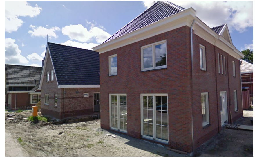
Nieuwbouw aan de Westerweg
