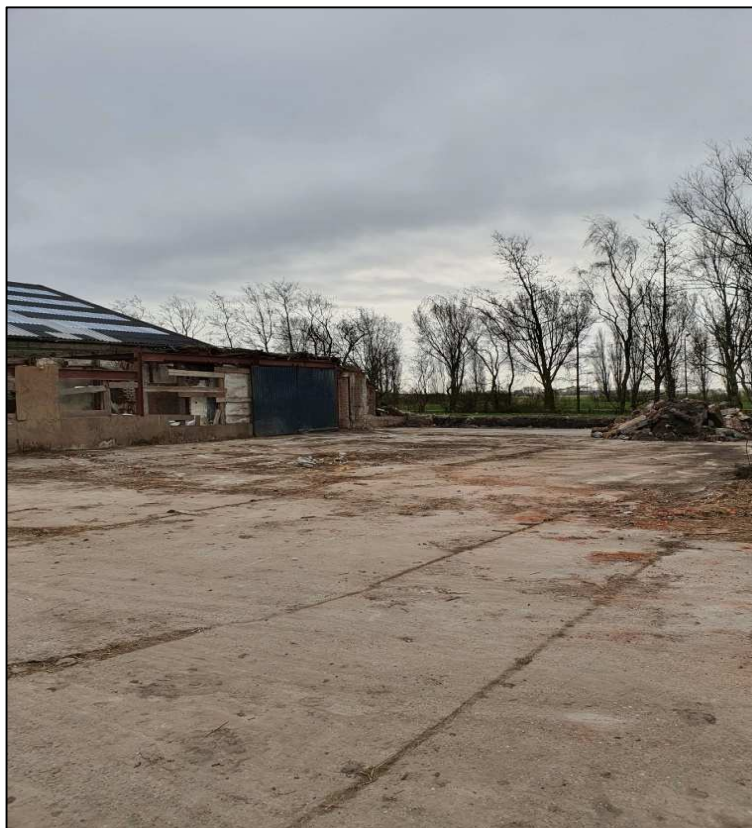
Fundamenten voormalige woonboerderij.
