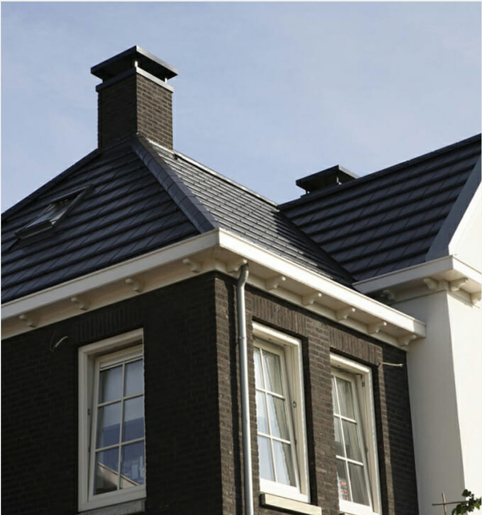
Geen rijk gedetailleerde dakgoten
