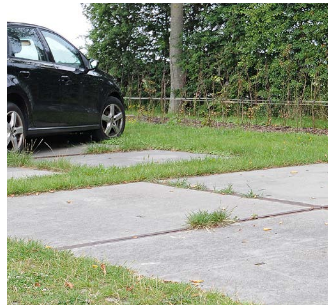
Referentie, parkeren op stelconplaten (foto: Aad Holkamp)
