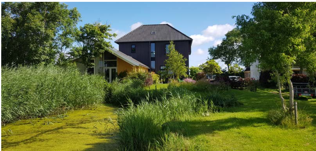
Vijver/ helofytenfilter achter de energieneutrale woningen
