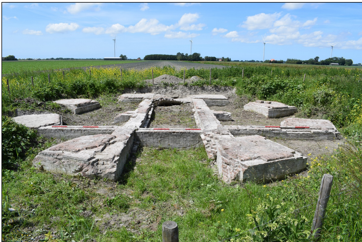
Afbeelding 13. De molen gefotografeerd vanuit de voorwaterloop. Zichtbaar is de keermuur die dwars op de waterloop is gemetseld.
