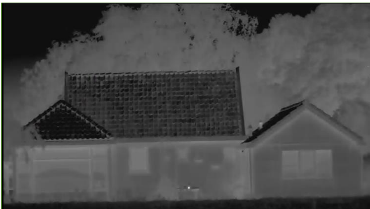
Figuur 6 Screenshot uit een videopname met de warmtebeeldcamera. Aanzicht vanuit het oosten richting de woning.
