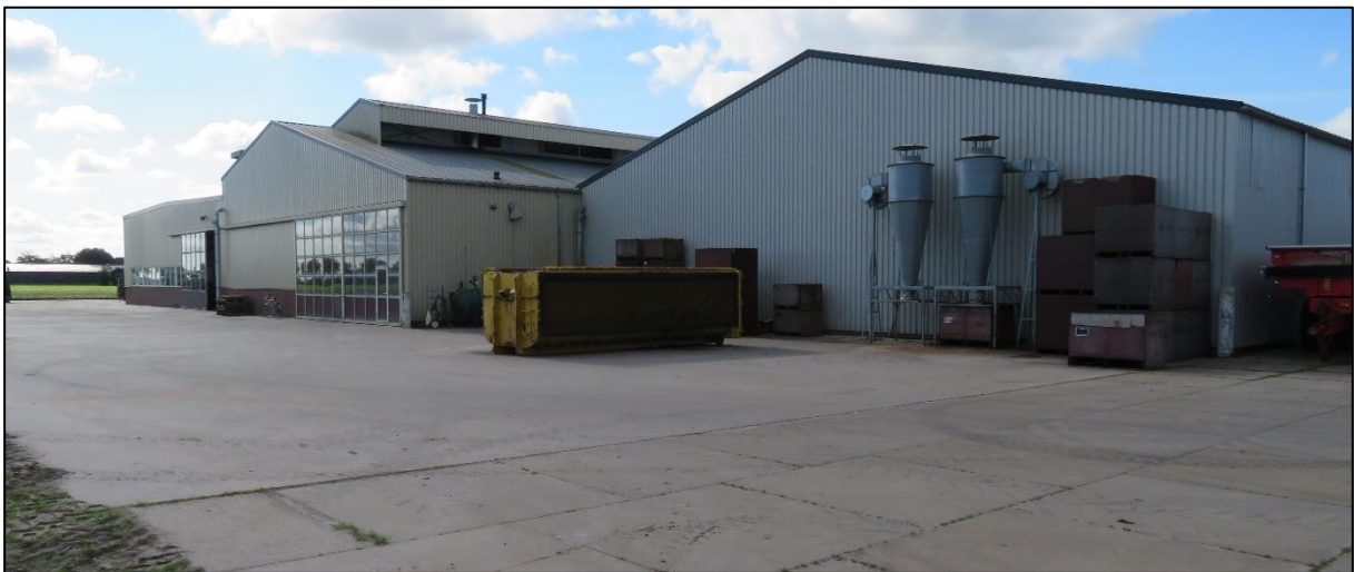
Afb 5: Achtergevels waartegen gebouwd gaat worden
