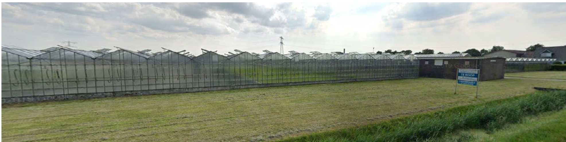
Kassencomplex gezien vanaf de Grasweg (foto van Google Streetview)
