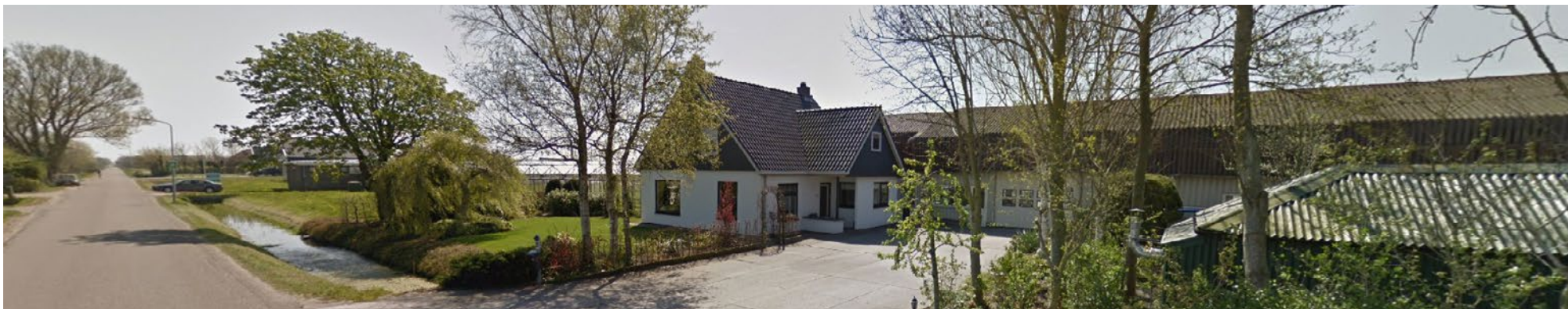
Bedrijfswoning aan de Grasweg met op de achtergrond de bedrijfshal (foto van Google Streetview)
