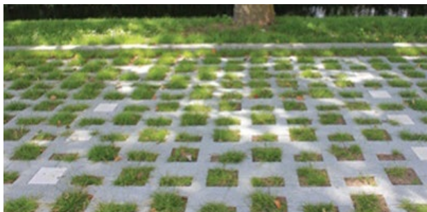
Referentie, parkeerplek grasbetontegel
